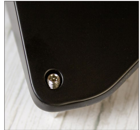
Die Ausleger erhöhen die Standfestigkeit, müssen aber selbst angeschraubt werden.
